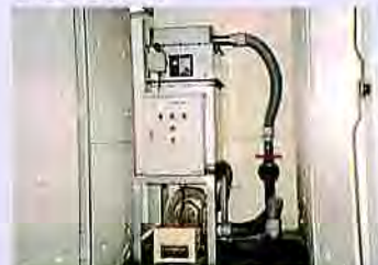
ディスポーザ浄化槽施設(マンション) ADO-200-K
